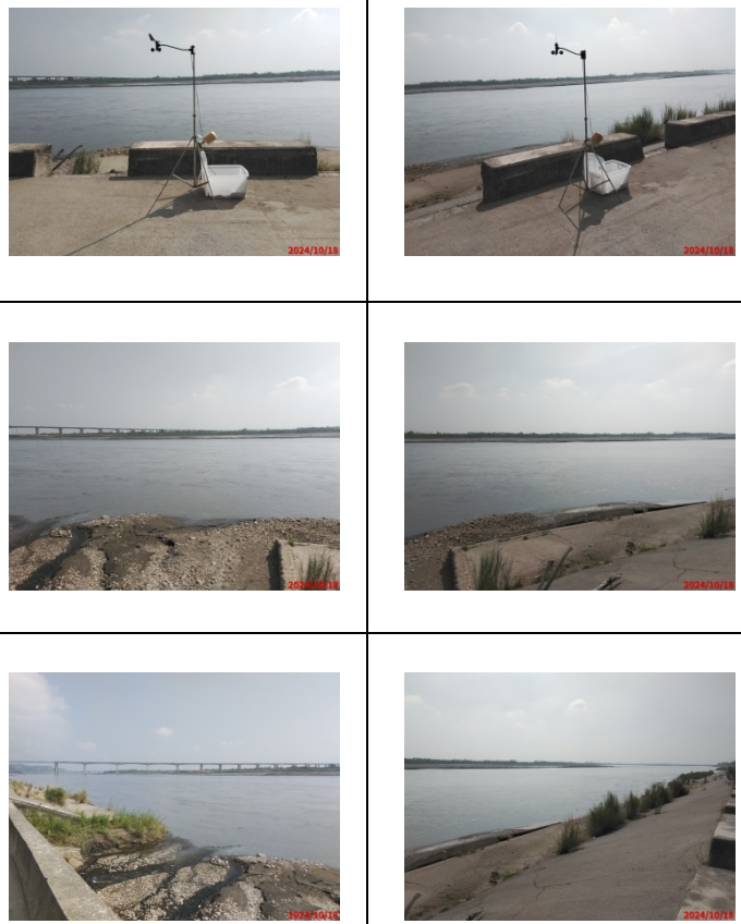
現地巡查照片
