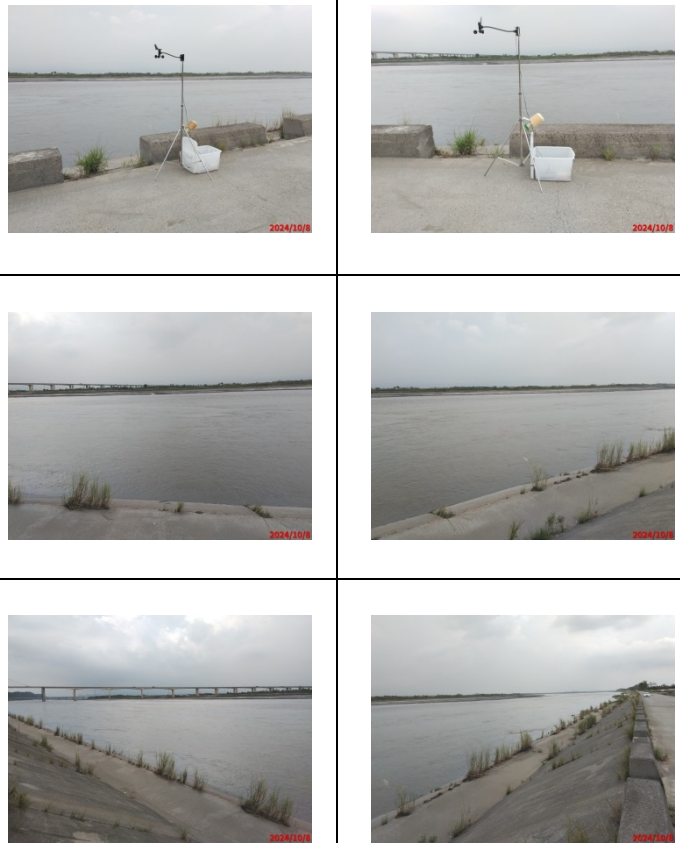
現地巡查照片
