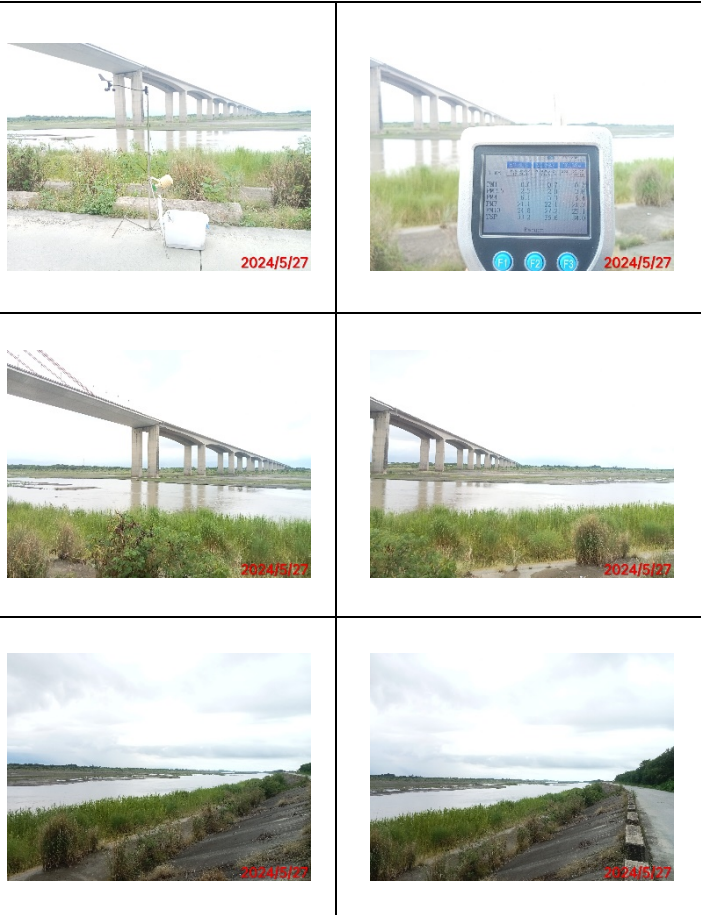
現地巡查照片
