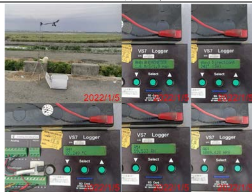
現地巡查照片
