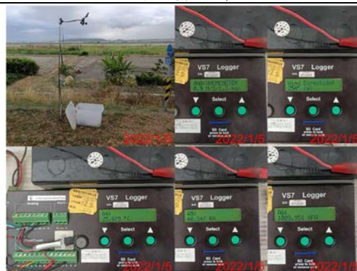
現地巡查照片
