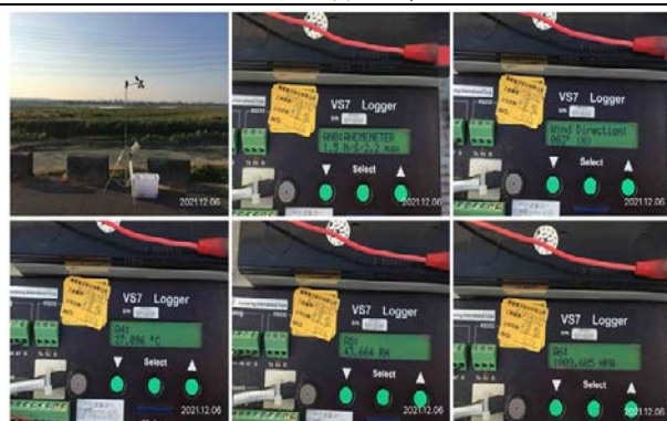
現地巡查照片
