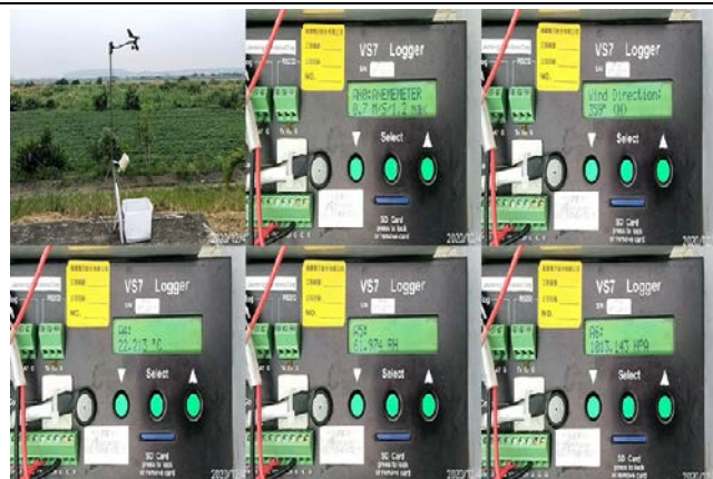
現地巡查照片
